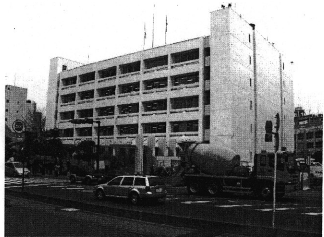
免震改修完了間近の厚木市庁舎(1/14)
